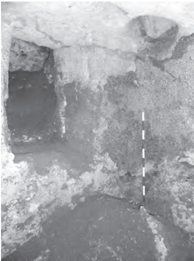
איור 10: חלל מקווה טהרה א' במערכת המסתור שבחורבת ג'בעית – מבט לעבר הפתח. שימו לב לטיח על דופן המקווה
